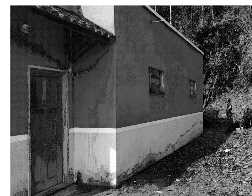
CONSTRUÇÃO DE BANHEIROS E CALÇADA
