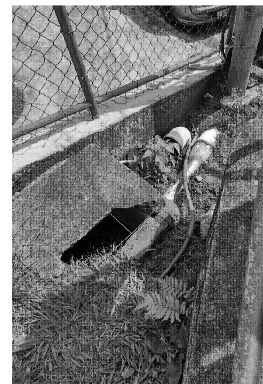
TROCA DA TUBULAÇÃO Ø200 CAIXA DE PASSAGEM .60x.60
